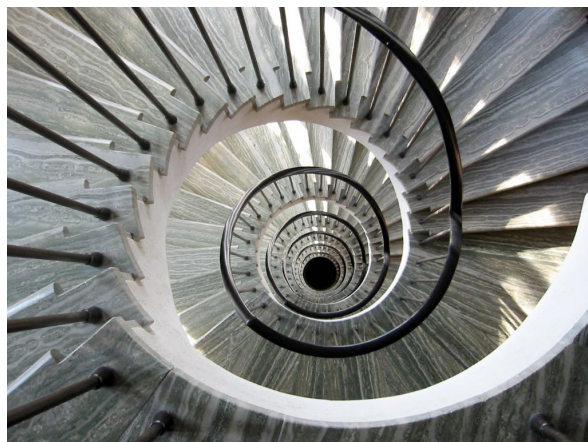
En typisk spiratrappa med ett typiskt hål som är typiskt dumt att ramla ner i.
